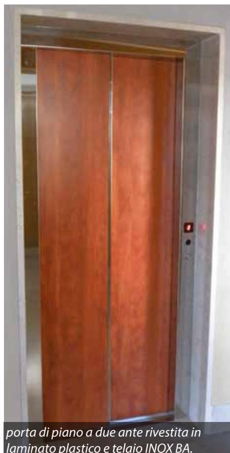
*porta di piano a due ante rivestita in laminato plastico e telaio INOX BA.*
