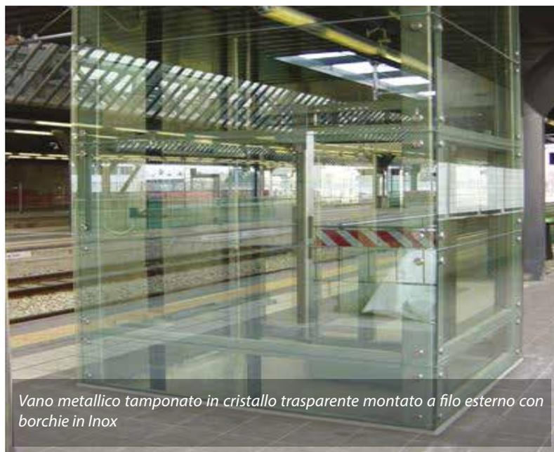
*Vano metallico tamponato in cristallo trasparente montato a filo esterno con borchie in Inox*
