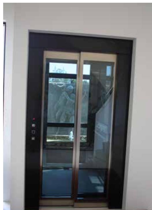
*Vano corsa in struttura metallica speciale con tamponamenti in cristallo a filo esterno fumè, porte in acciaio INOX panoramiche.*
