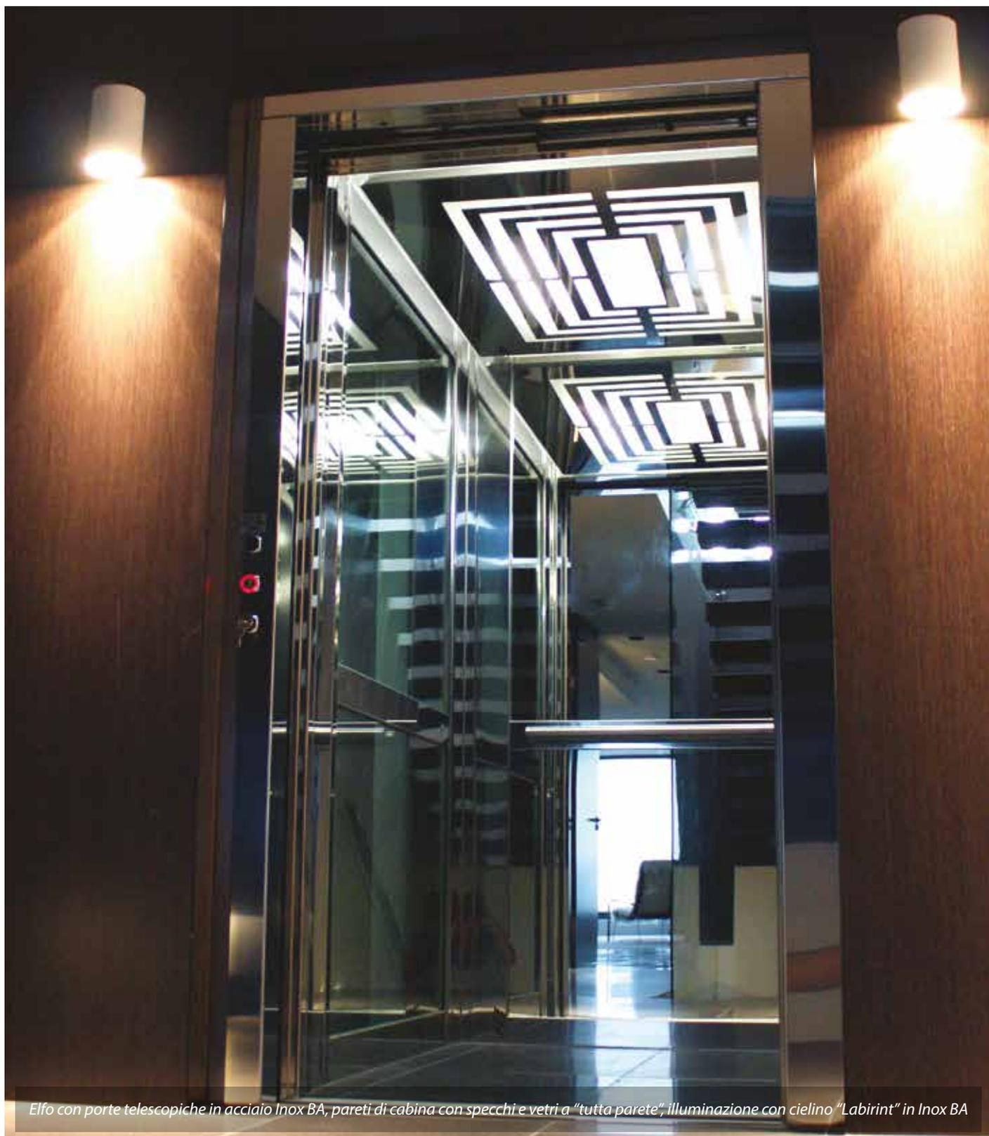
*Elfo con porte telescopiche in acciaio Inox BA, pareti di cabina con specchi e vetri a "tutta parete", illuminazione con cielino "Labirint" in Inox BA*
