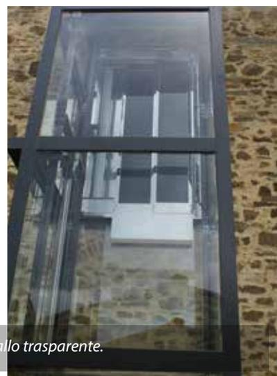
*Elfo con struttura a filo interno in acciaio zincato e verniciato a polvere per esterni, tamponato in cristallo trasparente.*
