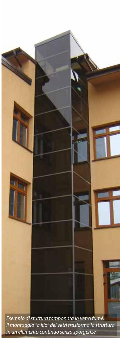
*Esempio di struttura tamponata in vetro fumè. Il montaggio "a filo" dei vetri trasforma la struttura in un elemento continuo senza sporgenze.*
